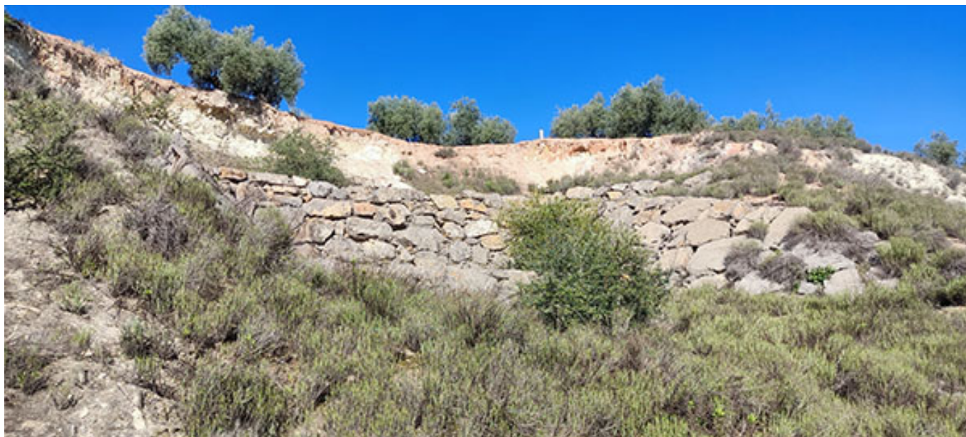
Muro de contención del talud (M. López Chicano, abril 2025)
