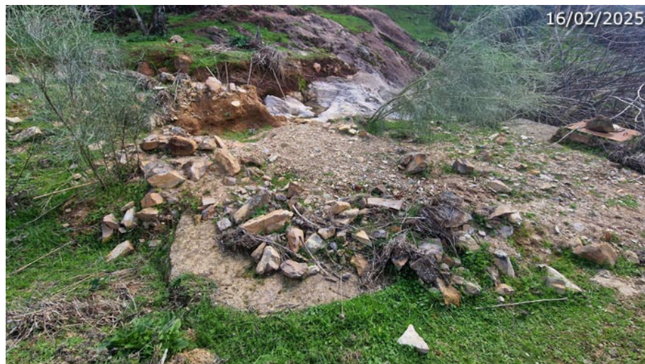
Aljibe junto al arroyo, semienterrado por una avenida de agua, al fondo la trampilla de acceso (A. Ventas, febrero 2025)
