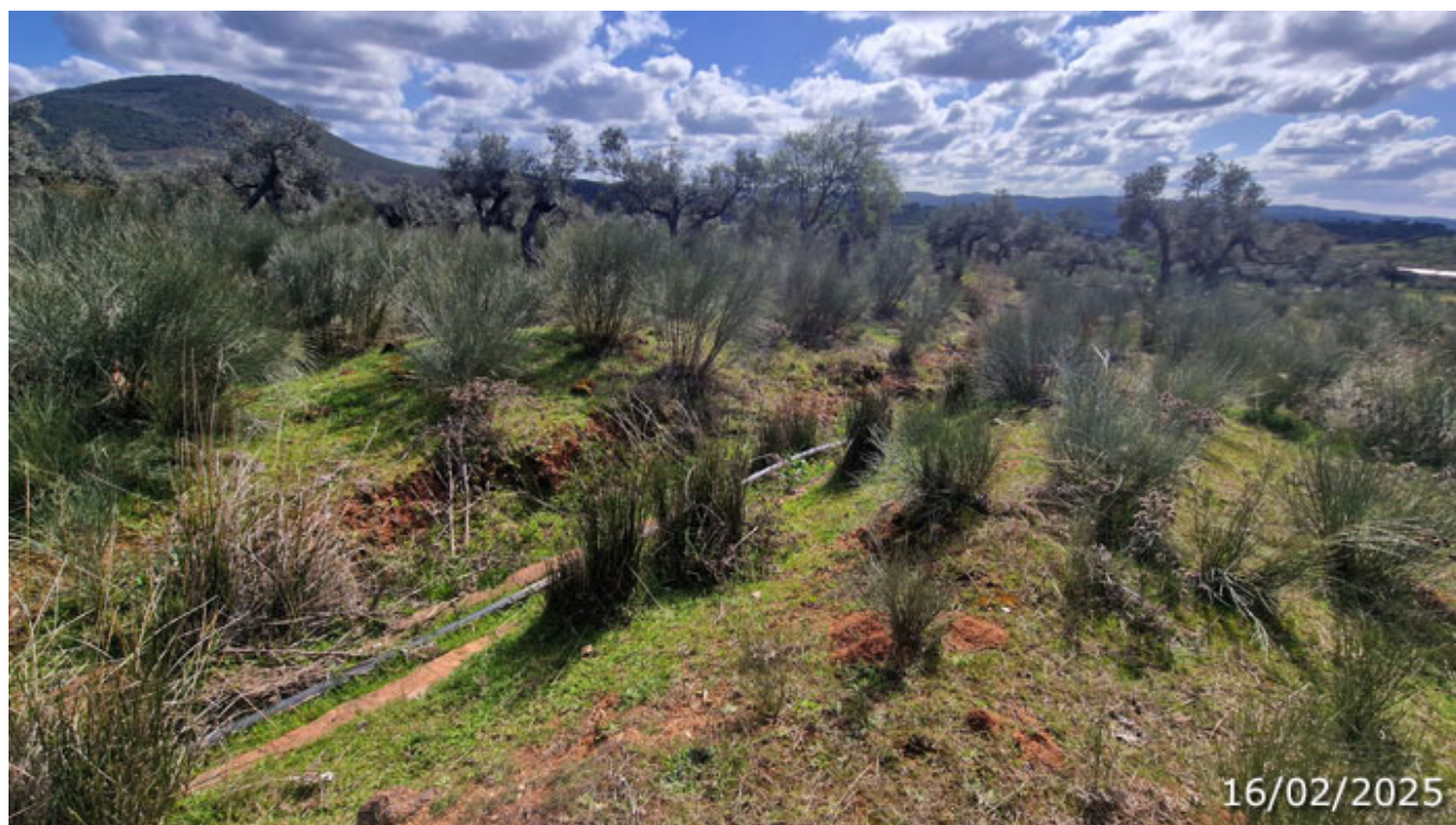
Conducción de polietileno en el interior de la parte final del zanjado con las aguas del nacimiento (A. Ventas, febrero 2025)
