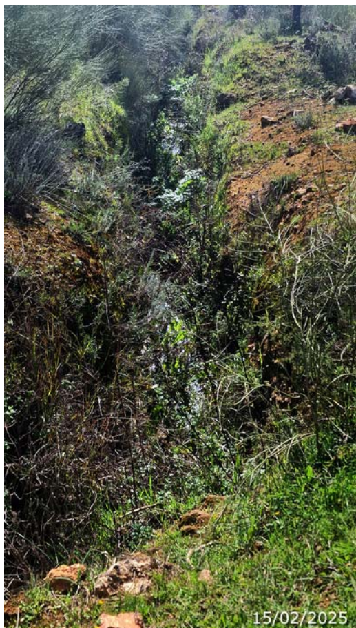
Zanja abierta tras el nacimiento (A. Ventas, febrero 2025)
