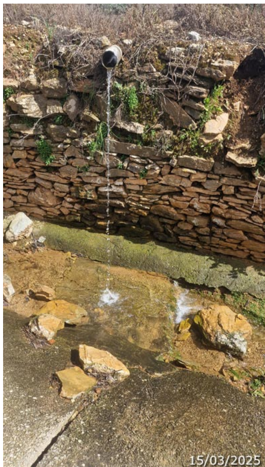
Aliviadero del agua de la fuente cuando no se usa para el riego de la huerta (A. Ventas, marzo 2025)
