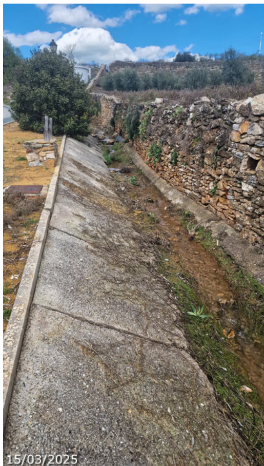
Cuneta de la calle con las aguas sobrantes de la fuente unidas a las del templete de El Cristo (A. Ventas, marzo 2025)
