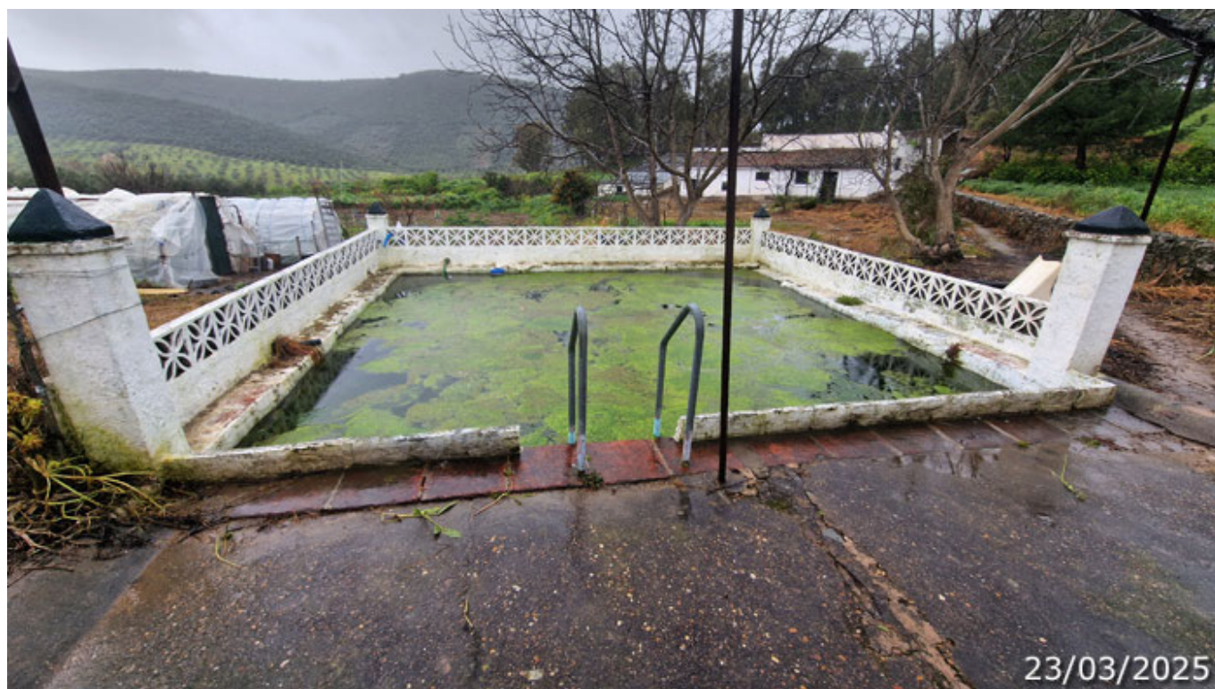
Conducción de agua sellada desde la fuente a la alberca (A. Ventas, marzo 2025)
