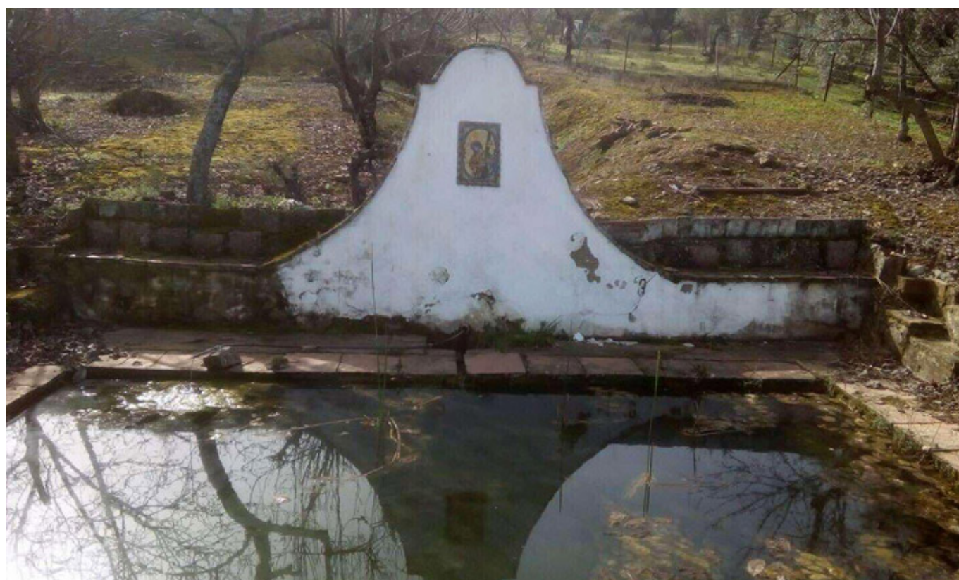
Fuente sin tanto caudal, con un chorrillo saliendo de la conducción del caño de la fuente (Juan Cabeza, febrero 2017)
