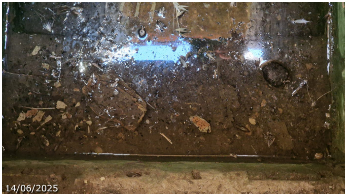
Nivel de agua, superando el primero de los escalones de acceso (A. Ventas, junio 2025)
