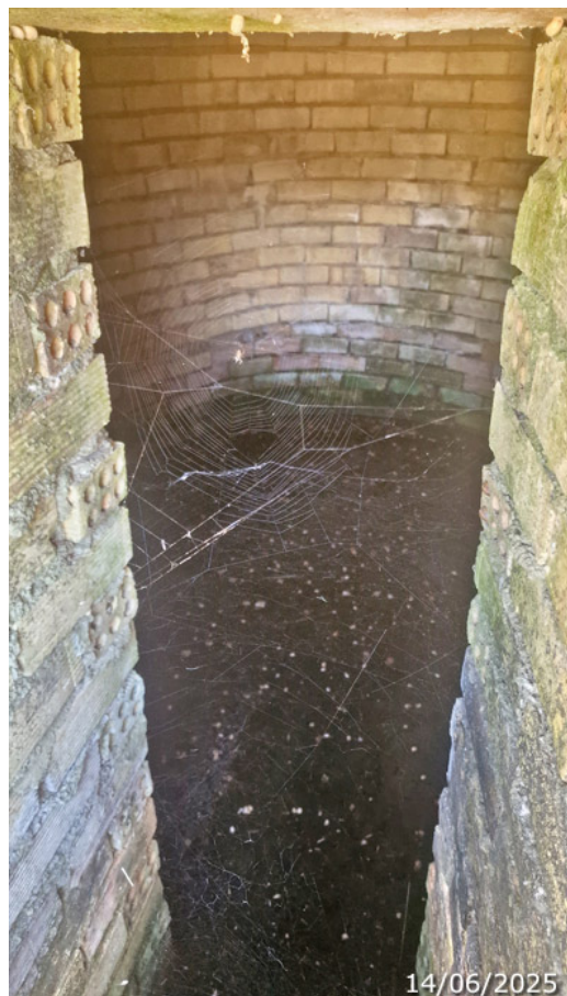
Interior del pozo enladrillado, con su pasillo de entrada (A. Ventas, junio 2025)
