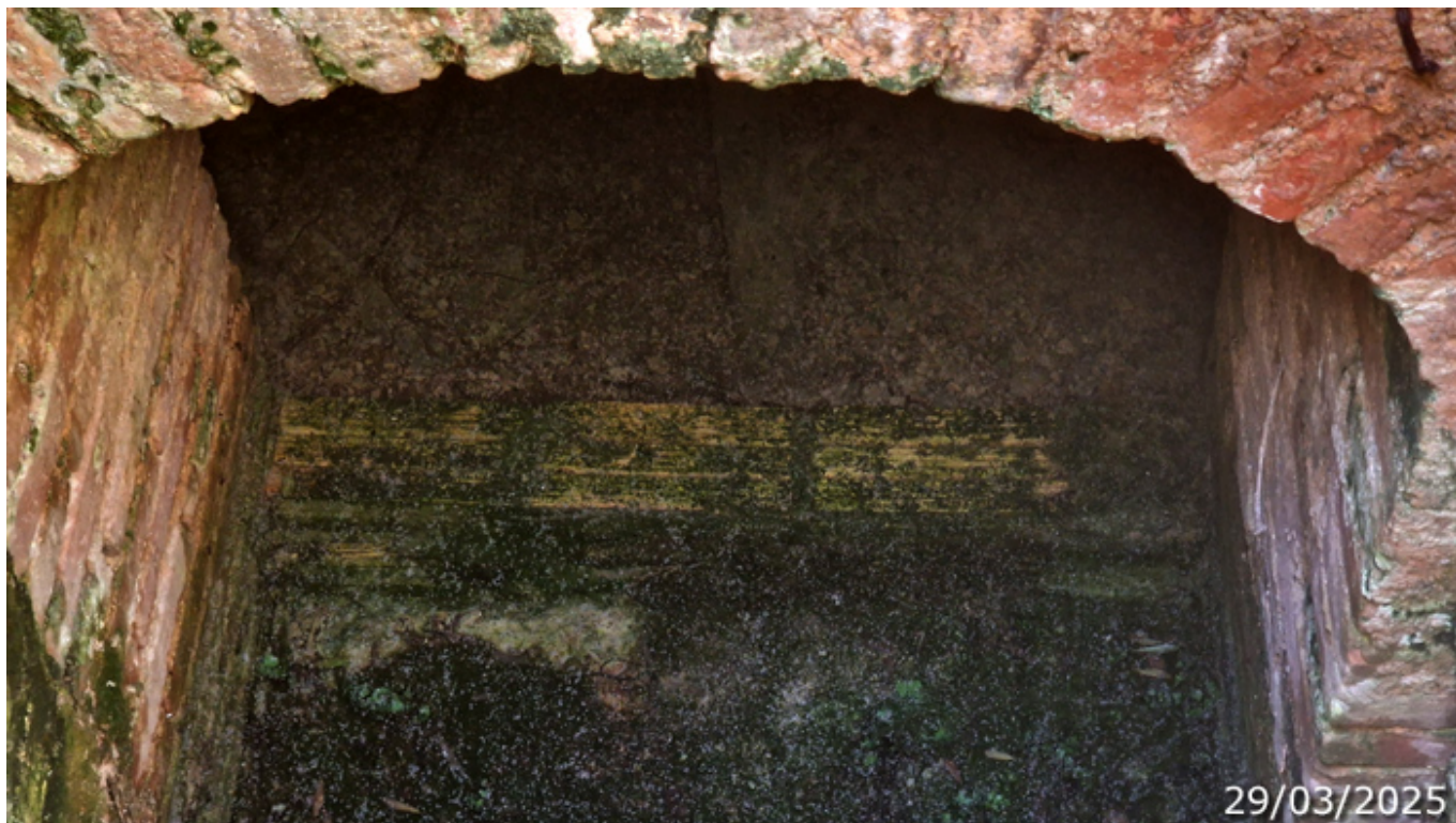
Detalle del suelo de la galería abovedada, con una represa para retener nivel de agua (A. Ventas, marzo 2025)
