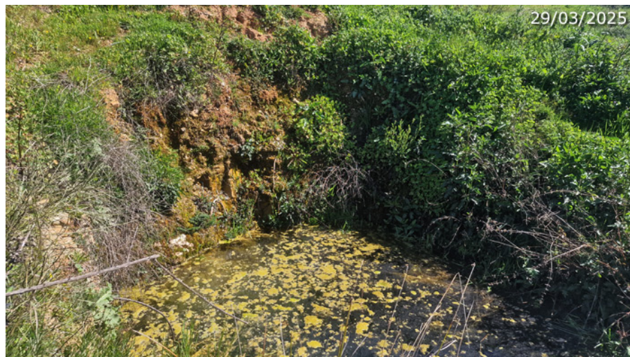
Poza recogiendo las aguas del rezume de la pared, excavada (A. Ventas, marzo 2025)
