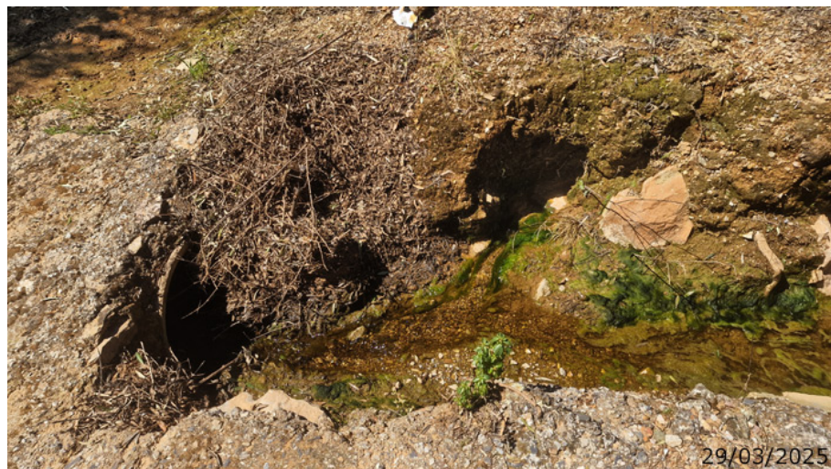
Afloramiento de la cuneta, en el centro (A. Ventas, marzo 2025)
