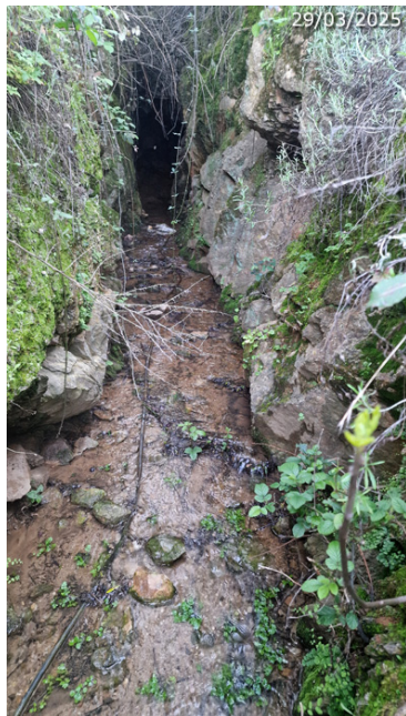
Tramo final del zanjado, con la galería del nacimiento al fondo (A. Ventas, marzo 2015)
