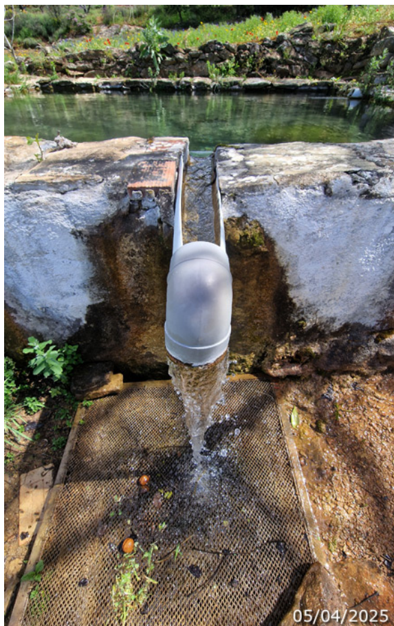
Detalle de la arqueta del suelo, con una rejilla, que recoge las aguas sobrantes de la alberca (A. Ventas, abril 2025)
