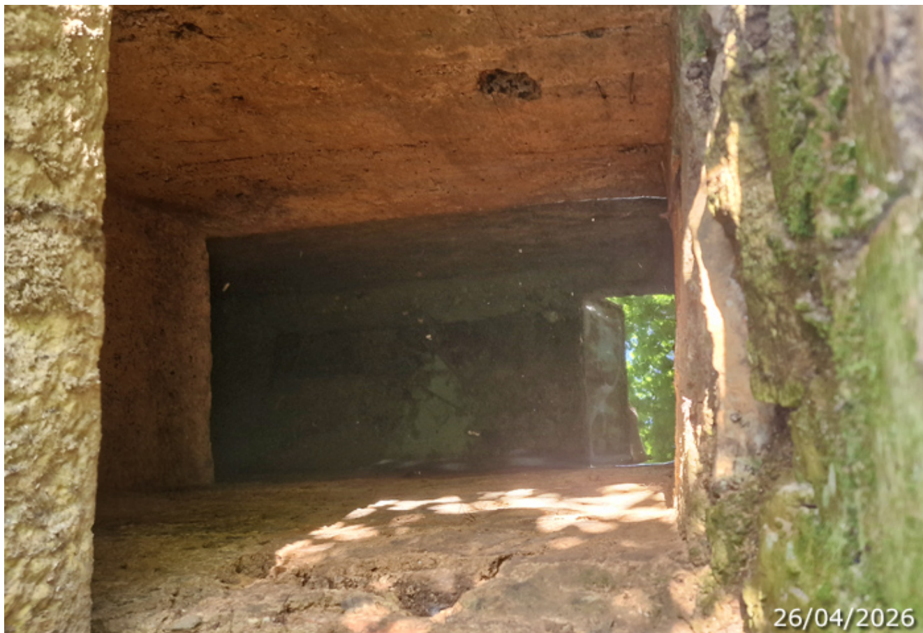
Detalle de la arqueta de registro, abierta, con agua al fondo, y canal en ambos lados (A. Ventas, abril 2026)
