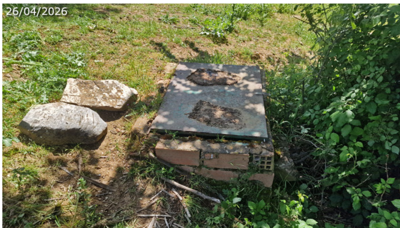
Arqueta de registro de lo que parece ser una galería con las aguas del nacimiento (A. Ventas, abril 2026)
