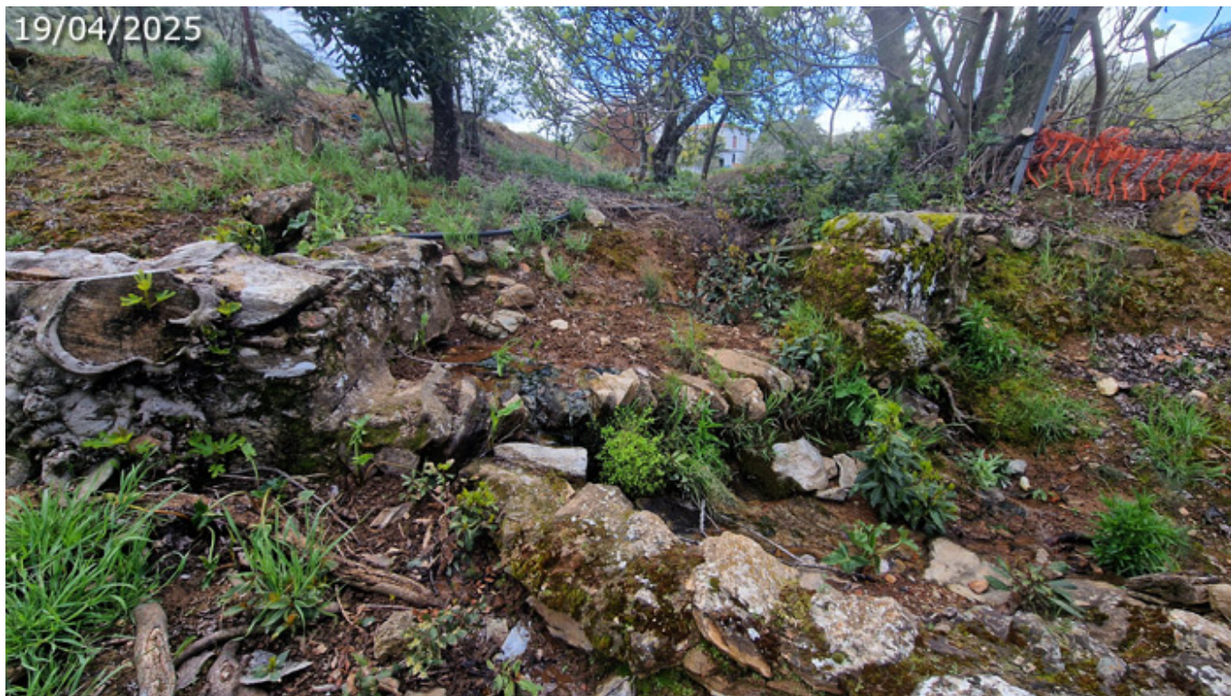
Represa y atarjea dos semanas después, casi sin agua en los manantiales. Al fondo, tras lo árboles, el Cortijo de La Atalaya (A. Ventas, abril 2025)
