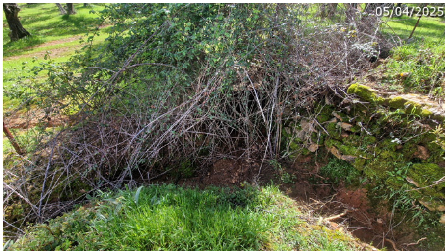
Muro del bancal que filtra las aguas del terreno originando el regajo (A. Ventas, abril 2025)
