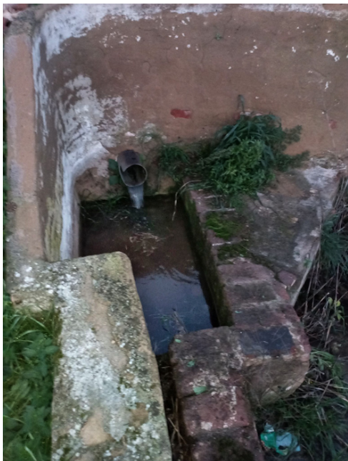
Fuente echando agua mostrando la pileta de recogida y su rebosadero, en la esquina de la alberca (A.M. Galván, enero 2025)
