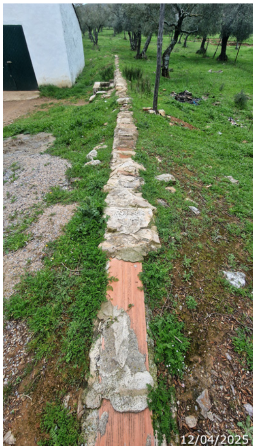
Tramo final, ya llegando a la fuente, de la atarjea con las aguas del nacimiento, situado unos 250 m más arriba (A. Ventas, abril 2025)
