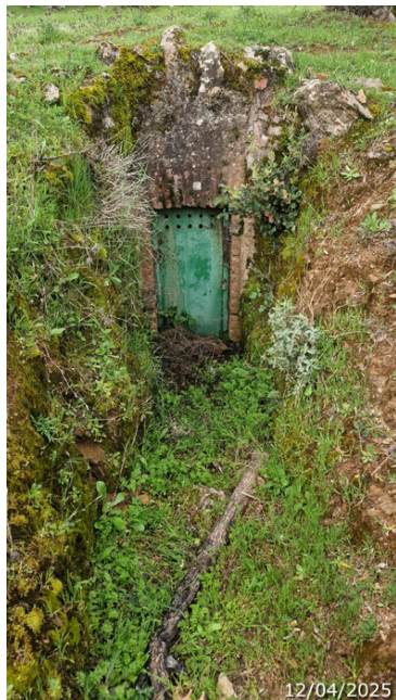
Entrada de la bocamina, con su portezuela de acceso en el fondo de un zanjado (A. Ventas, abril 2025)
