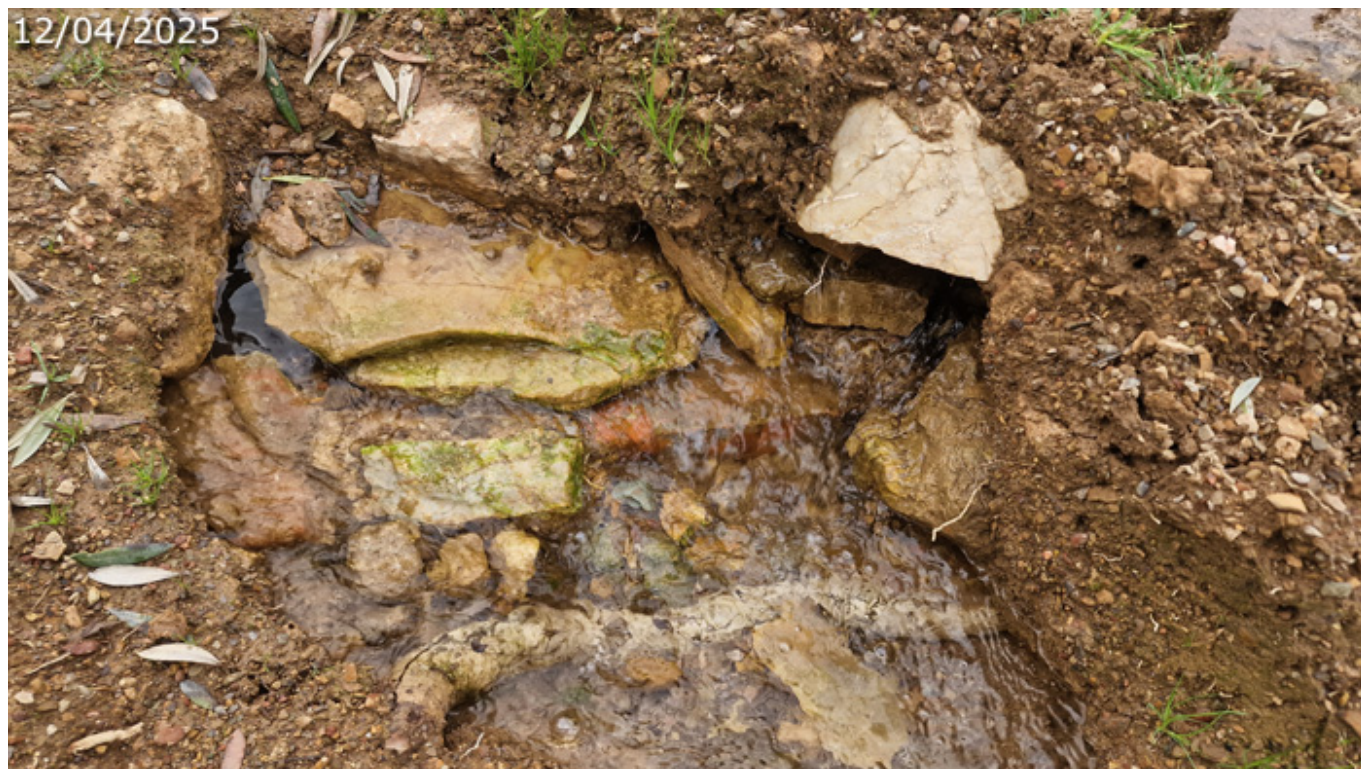
Detalle del afloramiento de la posible atarjea en el camino de subida al olivar, puede intuirse la pared de ladrillo mampostero (A. Ventas, abril 2025)
