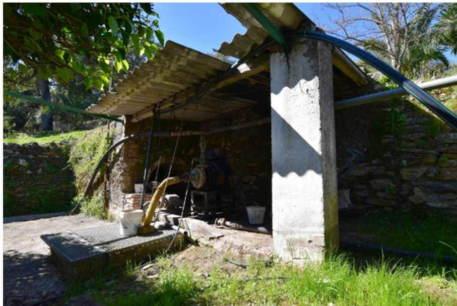
Manantial de la huerta de San Pedro, actual pozo manante y caseta de captación por bombeo (A. Márquez Pascual, febrero 2019)
