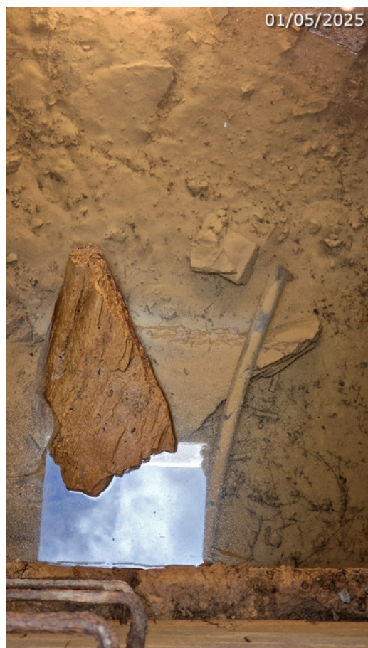
Fondo del agua mostrando el inicio de la conducción para su captación (A. Ventas, mayo 2025)
