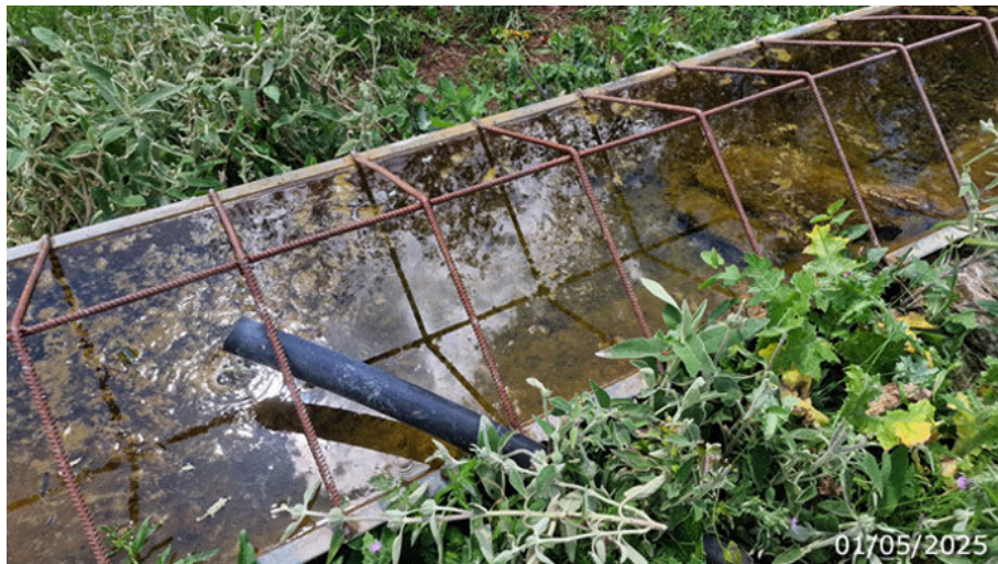
Abrevadero llenado con el agua de la fuente, que sale por la conducción de polietileno (A. Ventas, mayo 2025)
