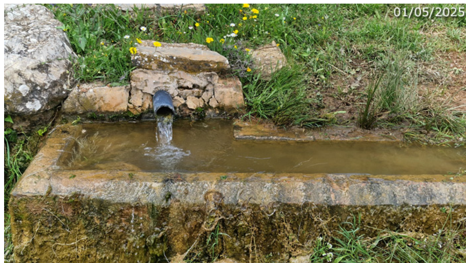
Fuente del pilar, vista de frente, con su pequeña pileta abierta al pilar (A. Ventas, mayo 2025)
