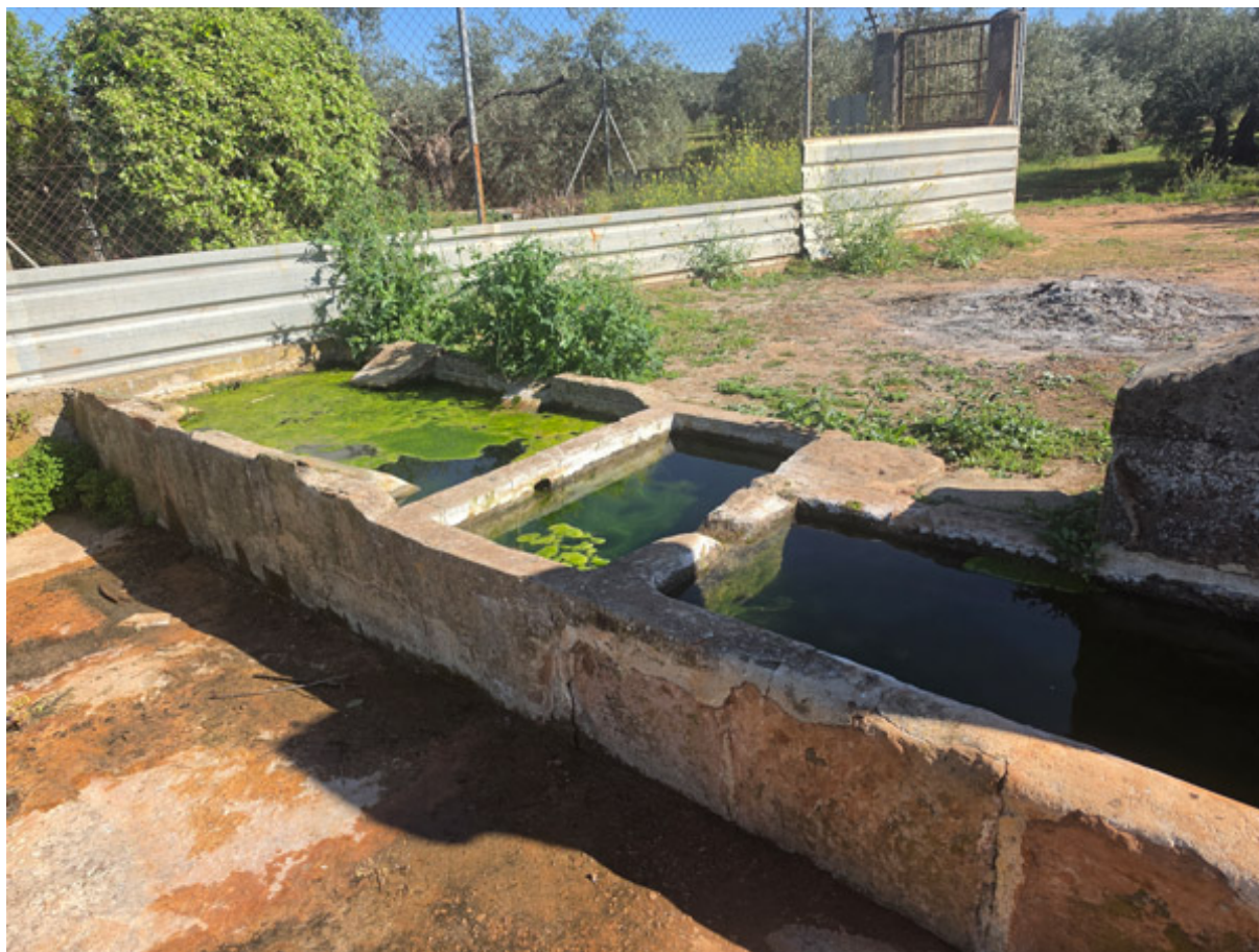
Pilas anexas a la fuente (D. Sánchez Garrido, abril 2026)
