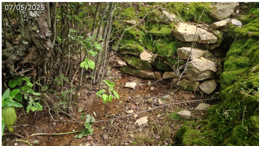
Murete de piedras bajo las que surge el manantial (A. Ventas, mayo 2025)
