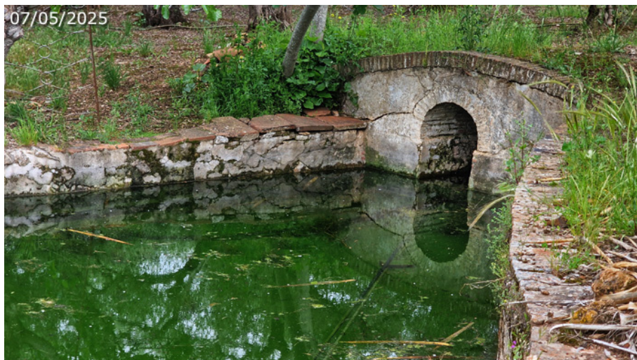
Alberca con la salida de agua desde la galería abovedada (A. Ventas, mayo 2025)
