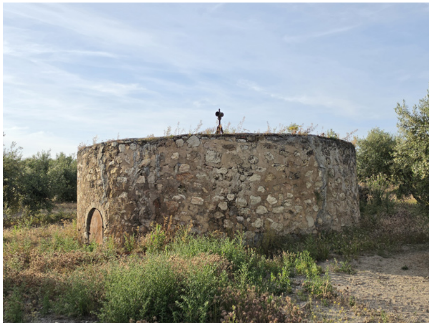
Vista del depósito o estructura de la Noria de Fuensomera (D. Sánchez Garrido, mayo 2023)
