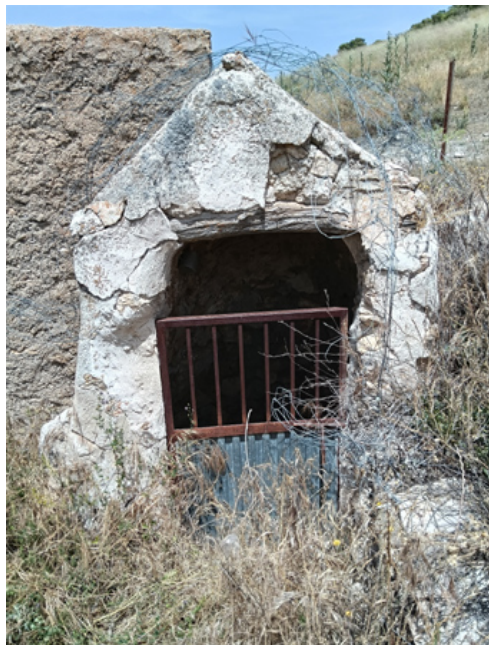
Vista de la caseta de protección de la fuente (J. F. Martín Álvarez, junio 2026)
