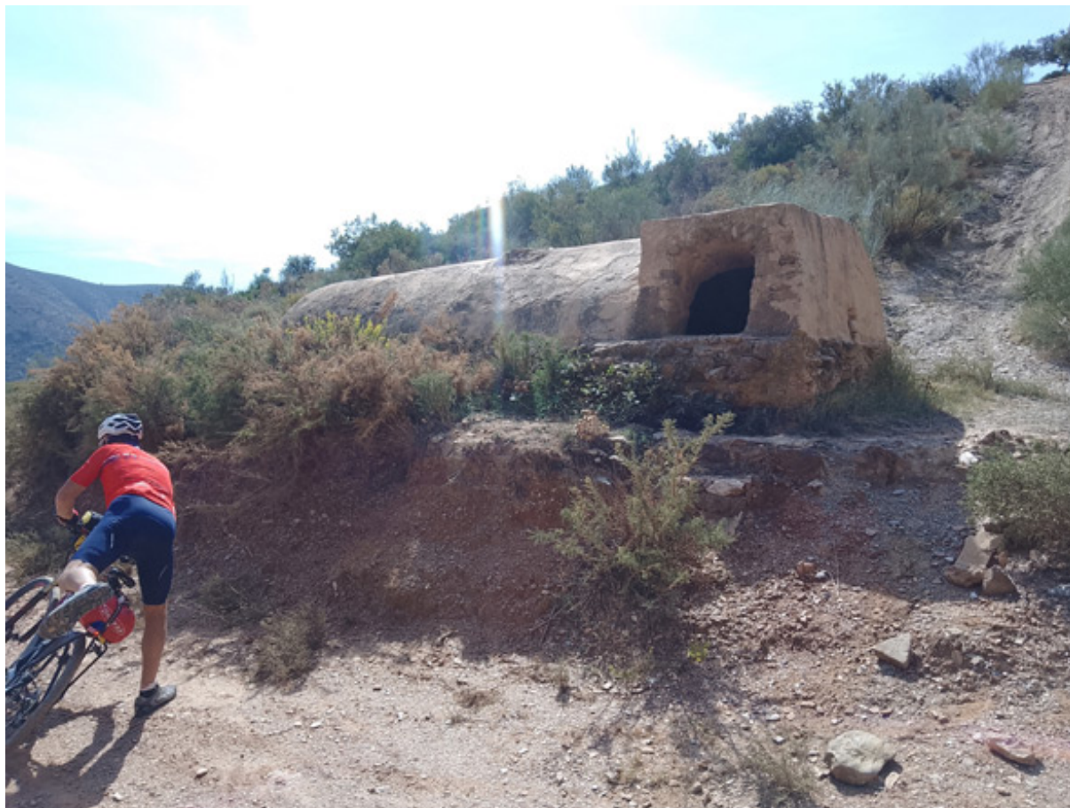
Boca de entrada al aljibe (F. Cuesta López, octubre 2023)
