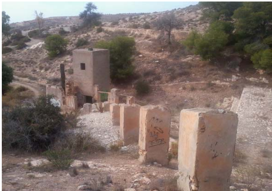
Pilares que sostenían la tubería que conectaba el agua del pozo con la acequia del Cauce de San Indalecio (E. Milla, octubre 2013)
