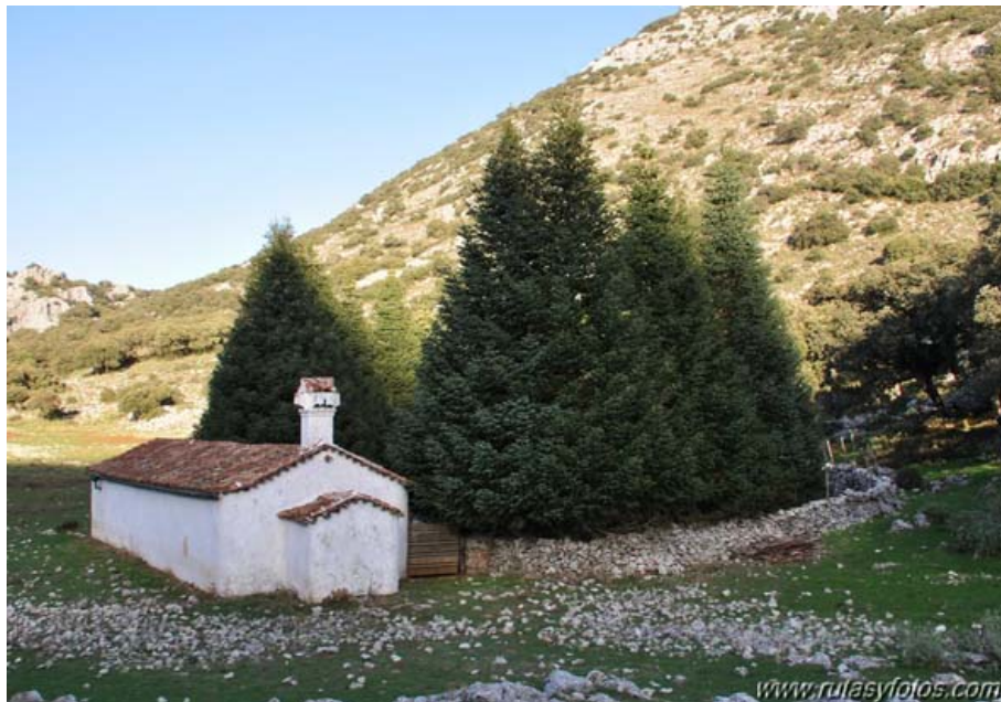
Aljibe de la Casa de los Navazos de Líbar (M. Limón Andamoyo, noviembre 2013)
