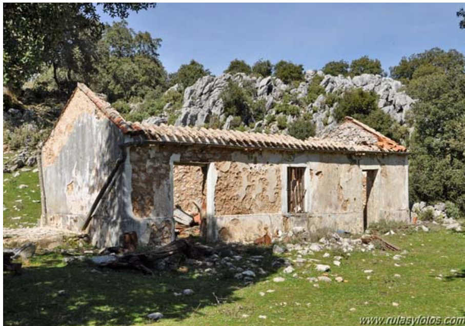
Casa del Aljibe (M. Limón, noviembre 2013)
