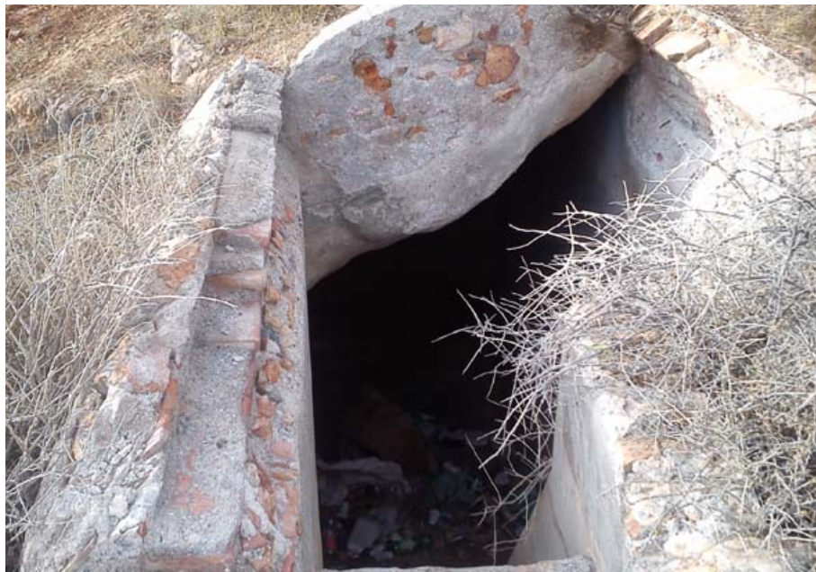
vista general del aljibe, donde se aprecia su entrada (E. J. Milla Juan, enero 2014)
