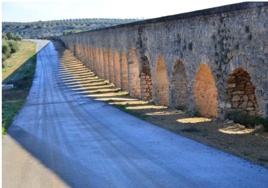
Acueducto de Caramago (J. Torres Garrido, diciembre 2014)
