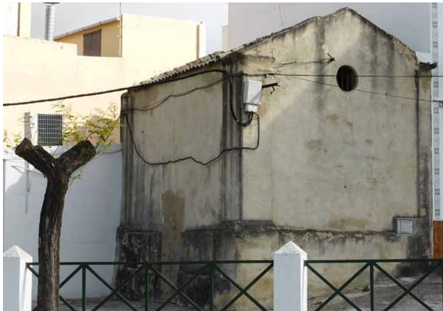
Edificación actual que contenía el antiguo pozo (P. Sánchez Gil, enero 2015)
