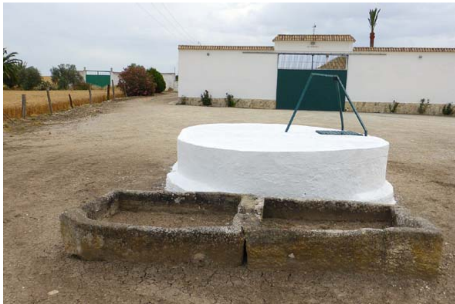
Situación del pozo respecto al cercano cortijo de la Norieta Baja (P. Sánchez Gil, enero 2015)
