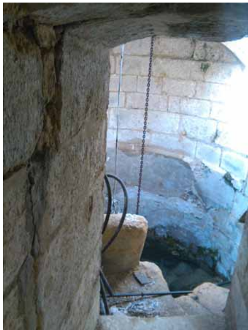
Acceso al interior del pozo. Se observa la escalera helicoidal de bajada y la sólida sillería de construcción (C. Barra, enero 2015)
