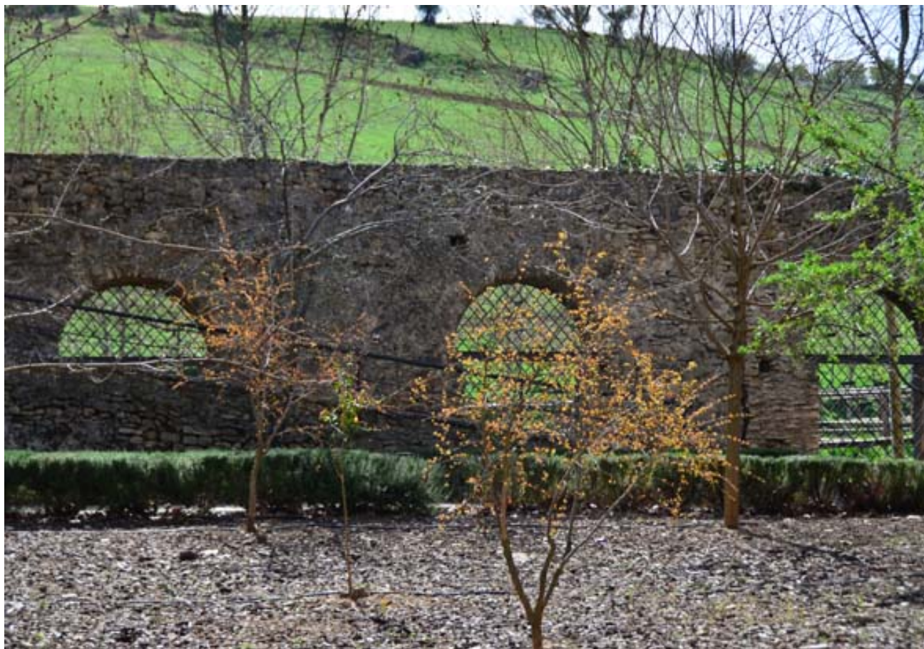
Acueducto (J. Torres Garrido, abril 2015)
