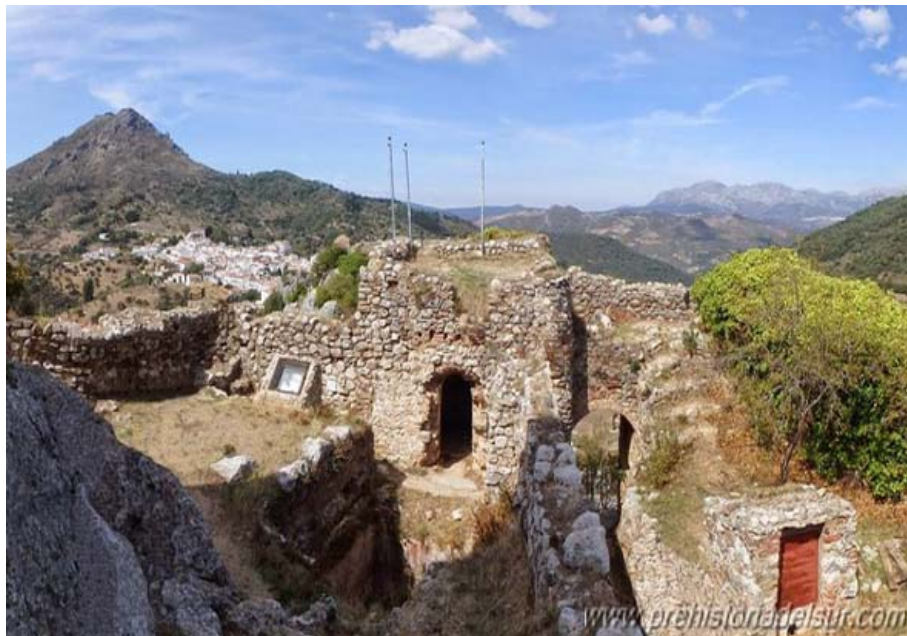
Aljibes de la zona superior (M. Limón Andamoyo, octubre 2015)
