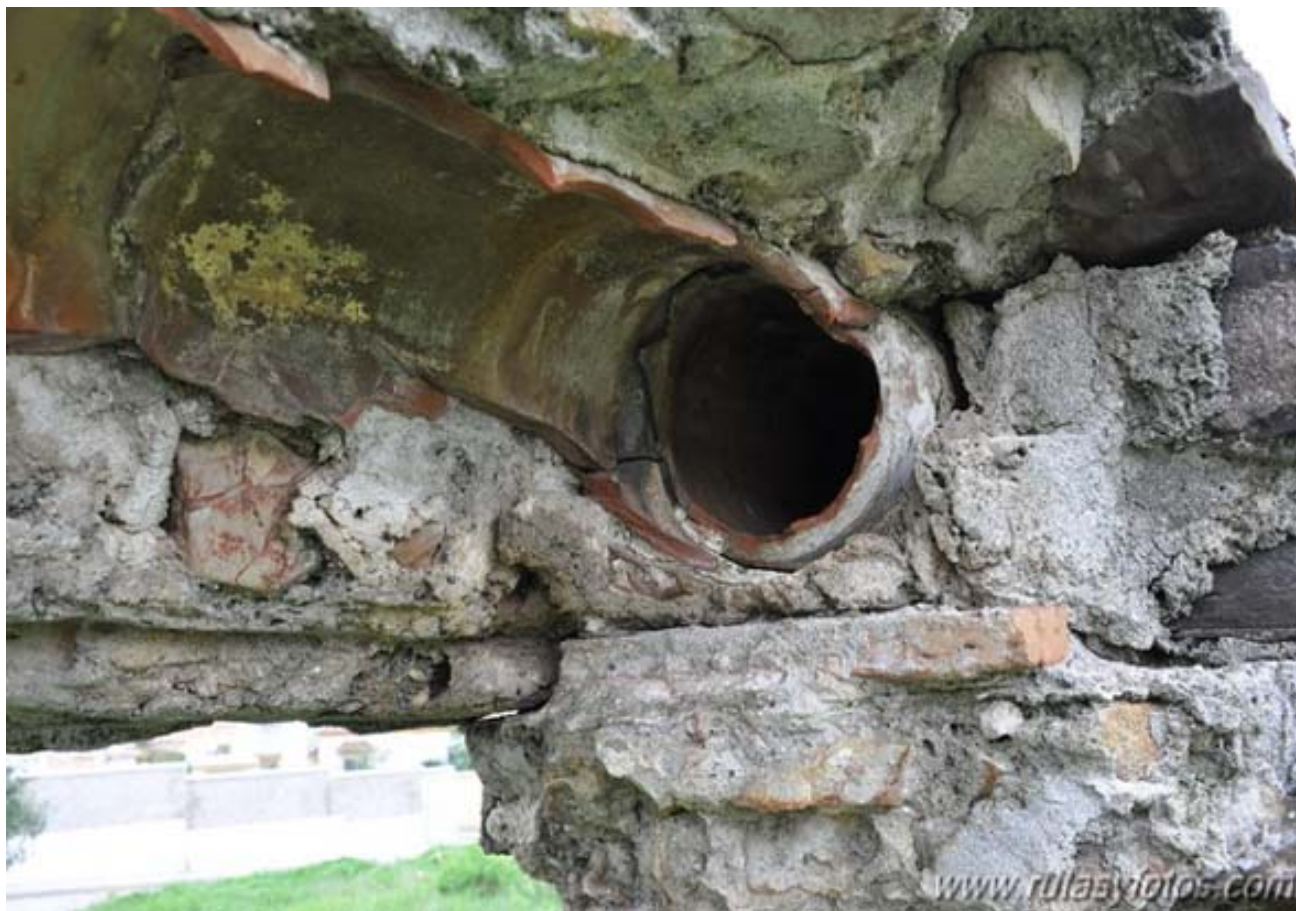
Los Arcos de El Cobre, tubería de la conducción (M. Limón Andamoyo, noviembre 2015)
