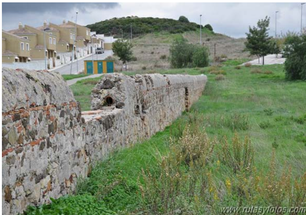
Los Arcos de El Cobre, comienzo de la conducción subterránea (M. Limón Andamoyo, noviembre 2015)
