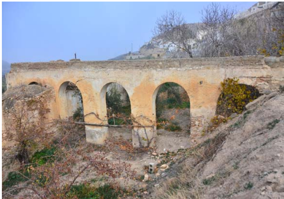
Acueducto del Molino (J. Torres Garrido, diciembre 2015)
