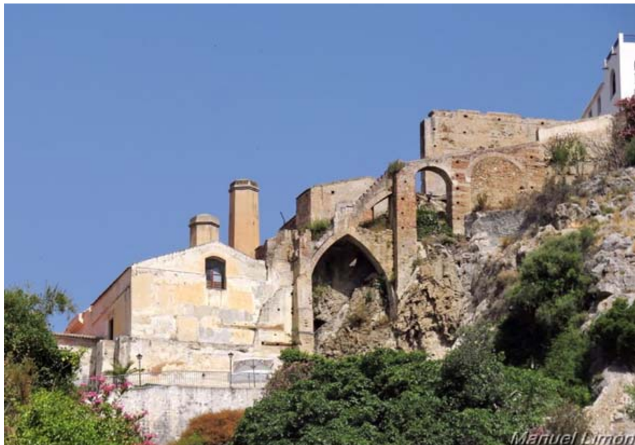
Sistema hidráulico de Las maquinillas y El Ingenio (M. Limón Andamoyo, septiembre 2016)
