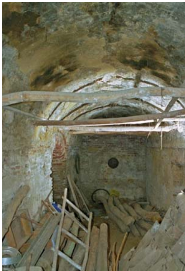
Interior de una de las salas ( www.ugr.es )
