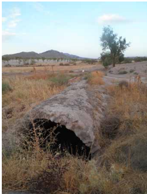
Aljibe del Ventorrillo (T. Peinado Parra, octubre 2016)
