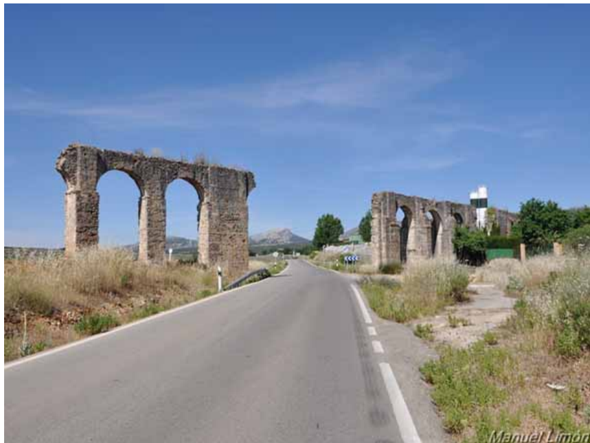
Acueducto de la Hidalga (M. Limón Andamoyo, enero 2017)
