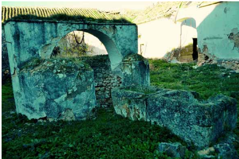
Pozo del Arenoso (J. Torres Garrido, diciembre 2016)
