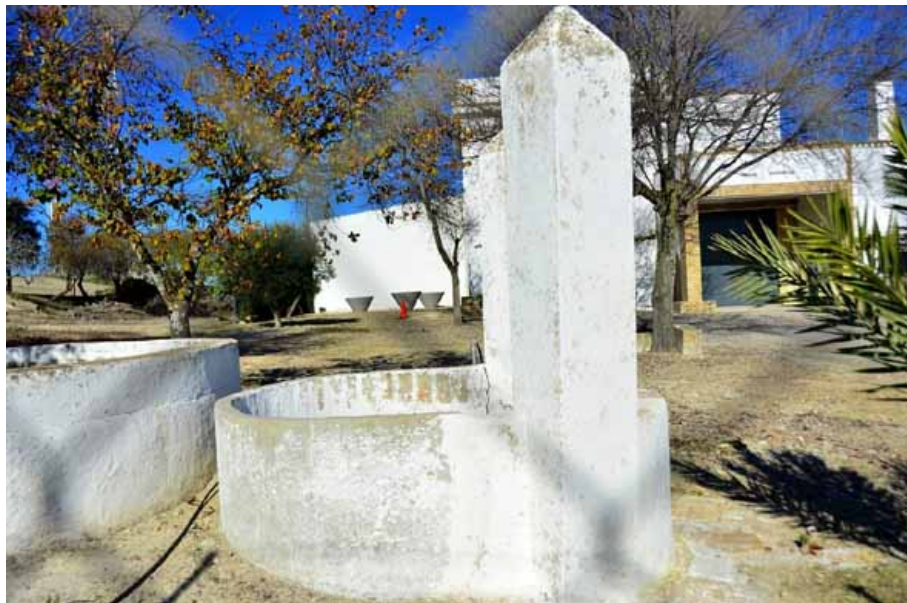
Pozo de Montoro (J. Torres Garrido, diciembre 2016)
