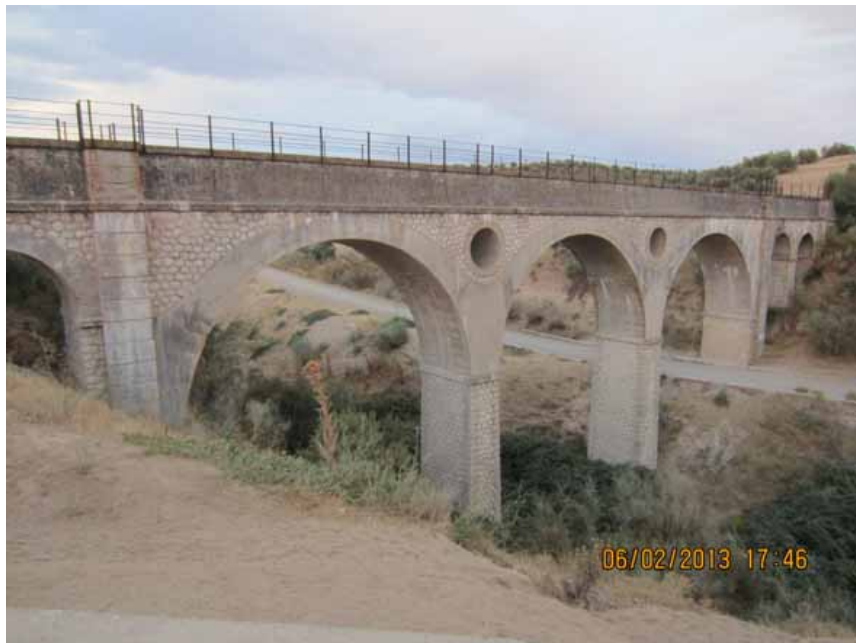
Acueducto del Canal de Cacin en Cijuela (J. Laserna Jiménez, febrero 2017)
