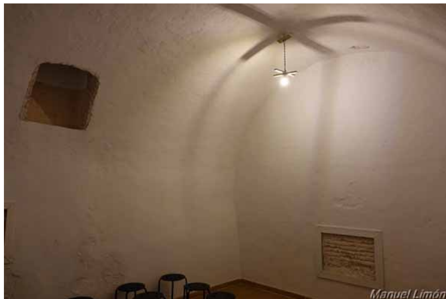
Aljibe con orificio de entrada de agua en el techo y conexión con el brocal en la pared izquierda (M. Limón Andamoyo, julio 2017)
