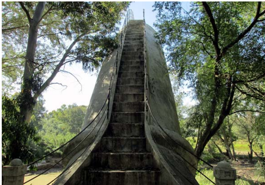
Sifón sobre el Guadalete ( www.panoramio.com , mayo 2013)
