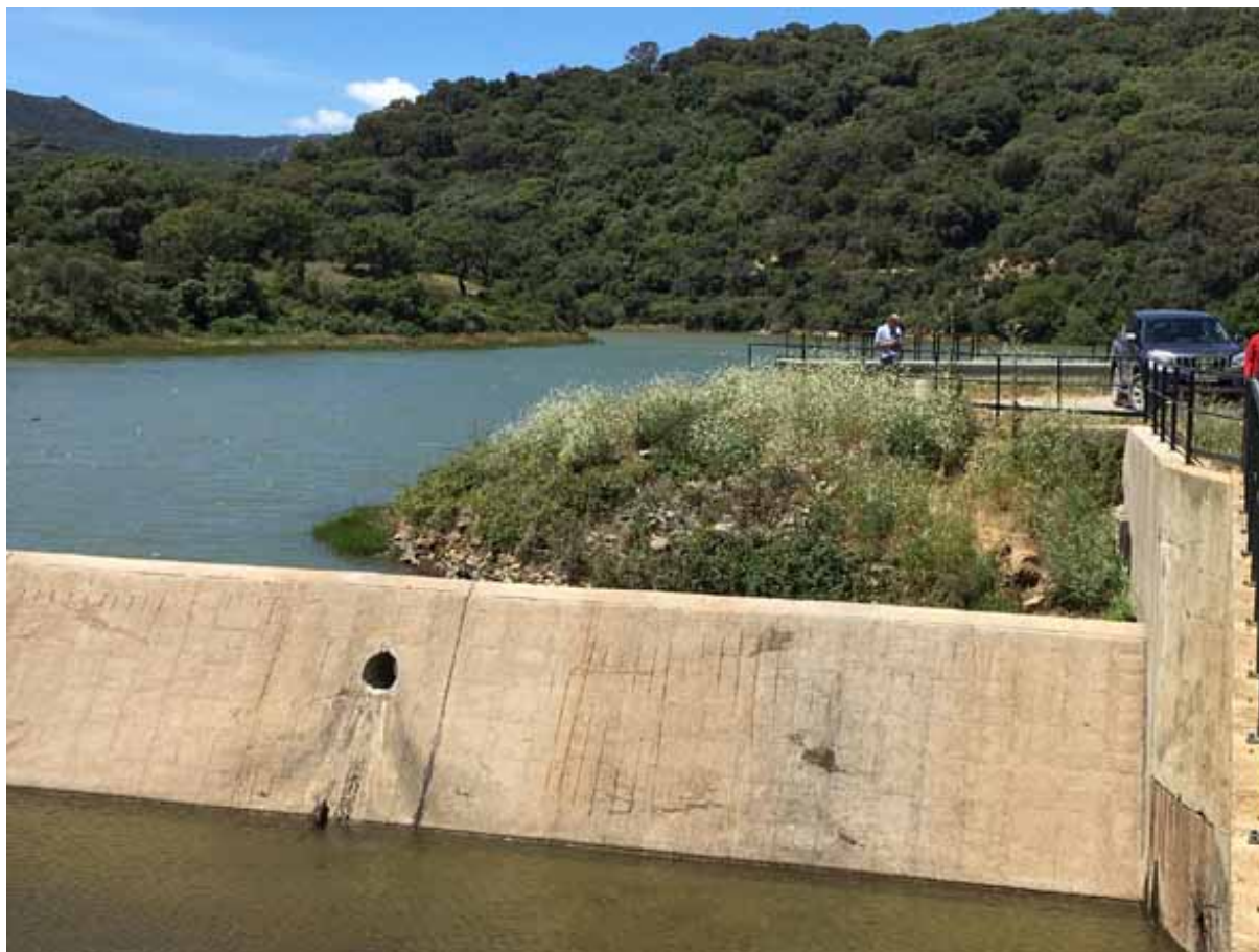
Detalle del aliviadero de labio fijo al que se le ha hecho un agujero de desagüe para disminuir la capacidad de retención (j. M. Fernández-Palacios, mayo 2019)
