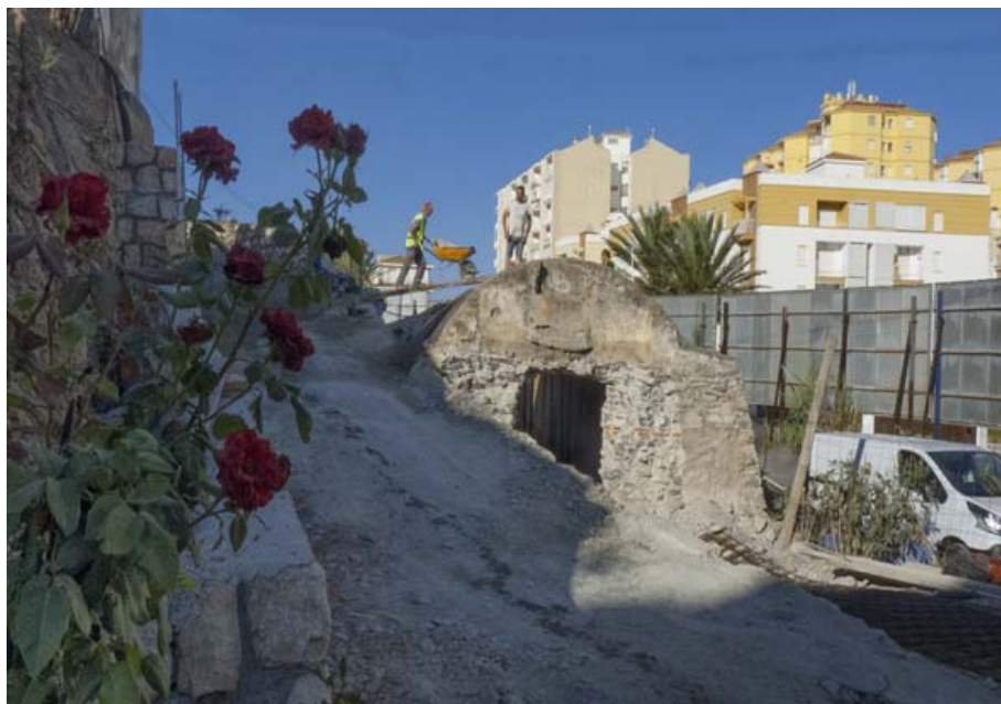
Aljibe de Torrenueva en restauración (J. Rubia González, junio 2019)
