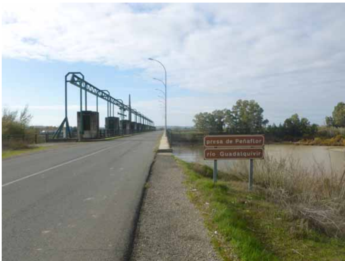
La presa de Peñaflor , más arriba y cercana a la Aceña. (R. Velasco Riejos, diciembre 2019)
