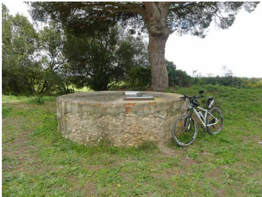
Pozo de los Ojuelos (M. Limón Andamoyo, abril 2018)
